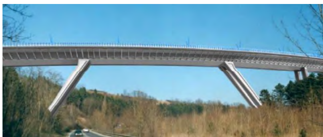
Obr. 27 Trámový silniční most
