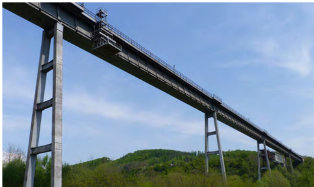
Obr. 26 Trámový nosný prvek, Ivančický viadukt (Wikipedie)
