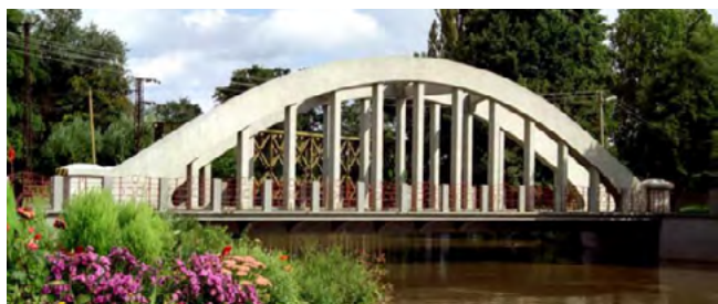
Obr. 22 Most se základní nosnou konstrukcí obloukovou, mostovka ve spodní části konstrukce
