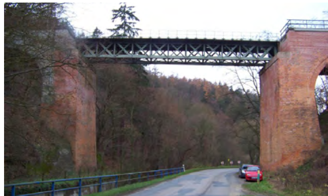
Obr. 28 Příhradový most – prostý nosník – na kamenných obloukových podpěrách
