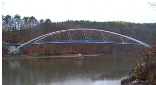
Obr. 23 Most se základní nosnou konstrukcí obloukovou s mostovkou mezilehlou
